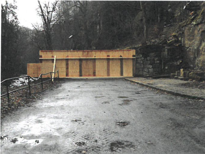
Verbau Richtung Liebethal
