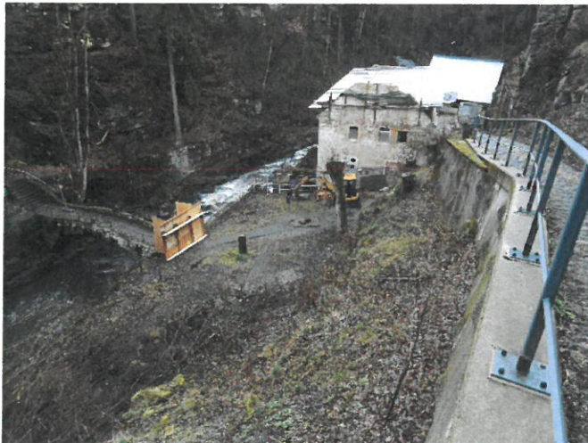
Verbau Richtung Daube
