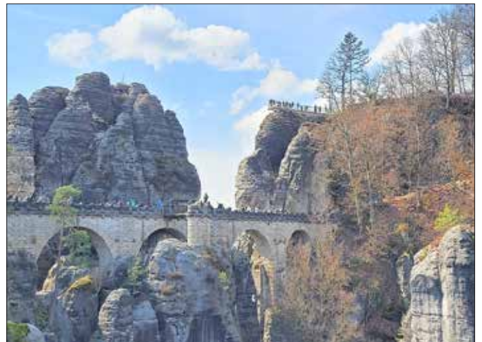
Blick zur Basteibrücke und Aussicht
