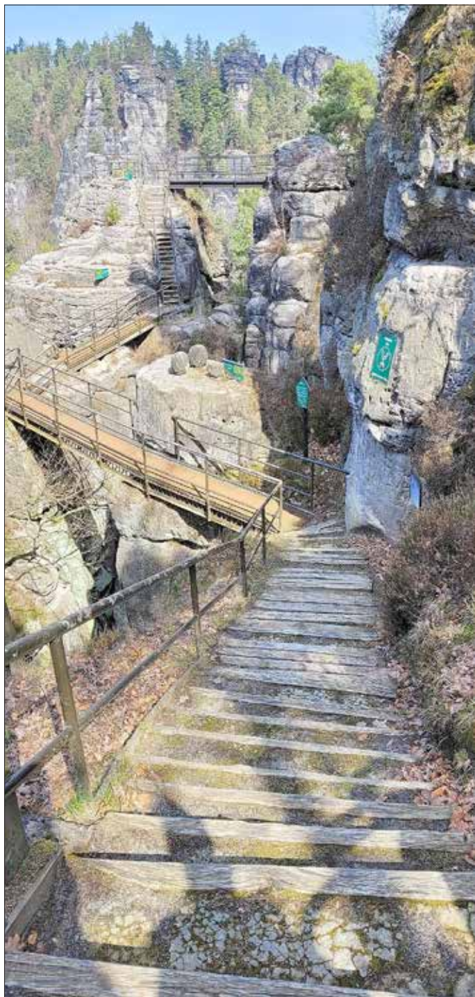
Der Beginn des Rundgangs der Felsenburg
